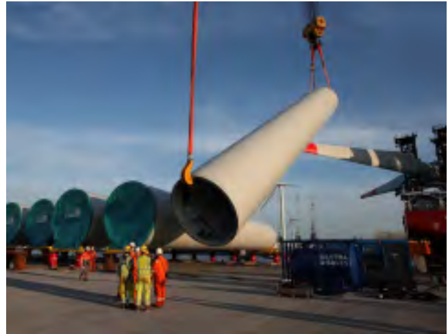
Hebevorgang einer Turmsection mit Axzion J-Hook und Axzion Pulley
